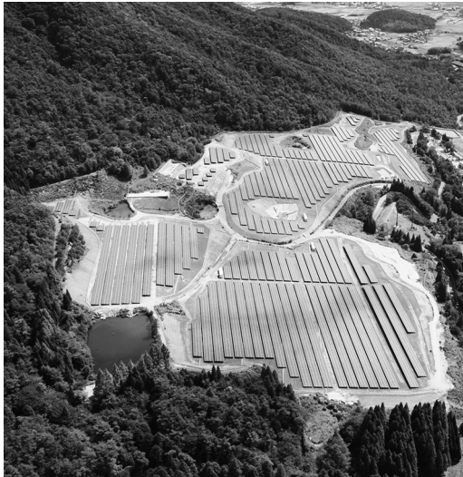
京都府岡岡市の太陽光発電所 7.5MW 元々あったゴルフ場の跡地を利用して 建設されたもの (いずみ市民生協)
