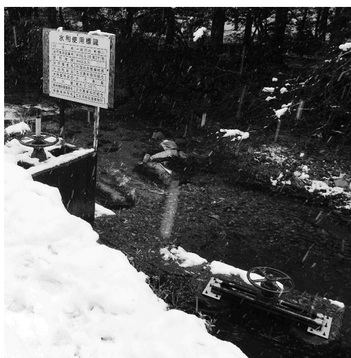
写真2 取水量等が厳密に定められている水利使用標識
